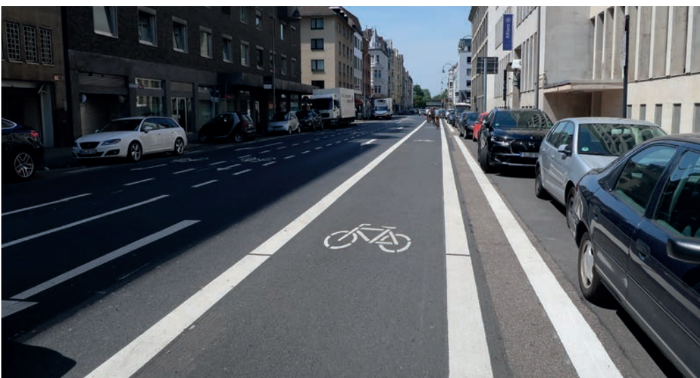
Radfahrstreifen mit Sicherheitstrennstreifen zum ruhenden Verkehr
