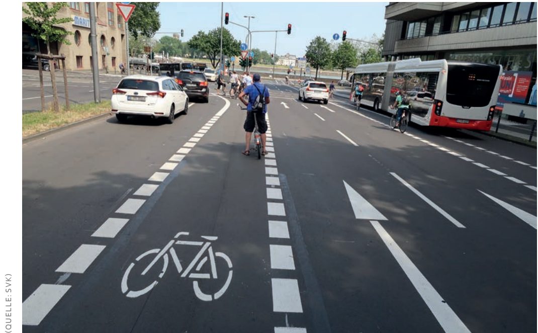
Führung des Radverkehrs mittels Markierungslösung bei mehrstreifiger Fahrbahn
