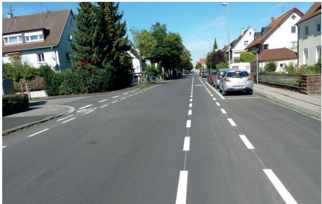
Schutzstreifen mit Sicherheitstrennstreifen zum ruhendem Kfz-Verkehr
