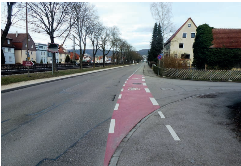
Aalen: Radwege können mittels Furtmarkierungen in einen Schutzstreifen übergeleitet werden.
