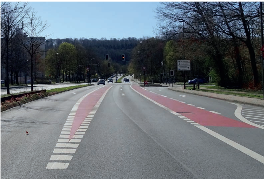
Weiche im Zuleitungsbereich eines Knotens verdeutlicht die Radverkehrsführung.
