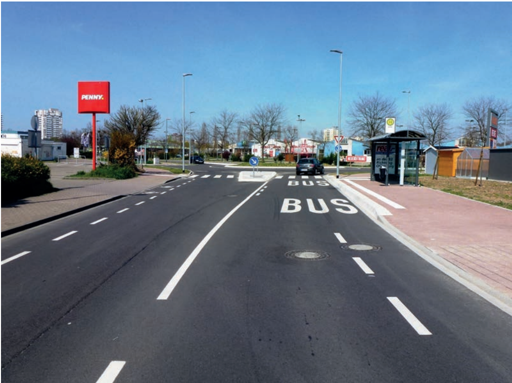
Laehr: Unterbrechung von Schutzstreifen im Bereich von Haltestellen
